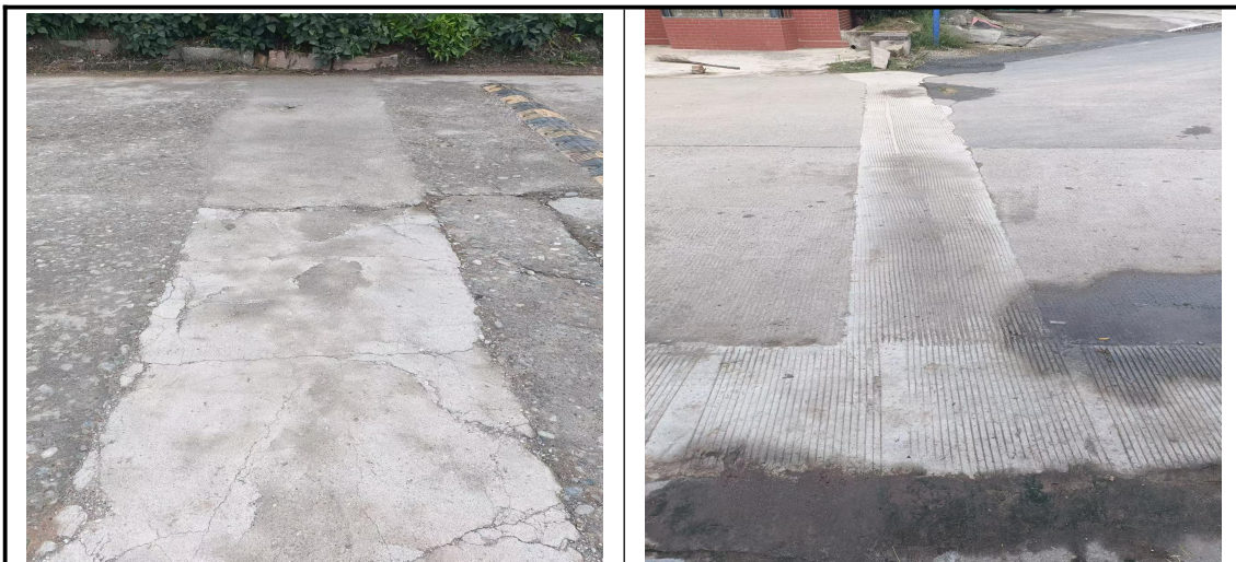
图 4-1 2024 年 12 月对管网工程进行现场检查
